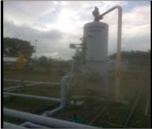
**Gambar 2.7. Separator Vertikal**
