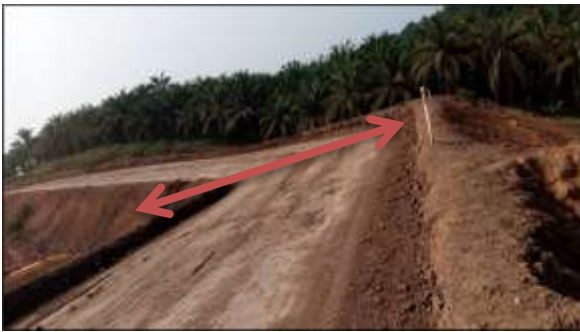
Gambar 4.3 Lebar Jalan Angkut Tikungan pada Segmen E-F
