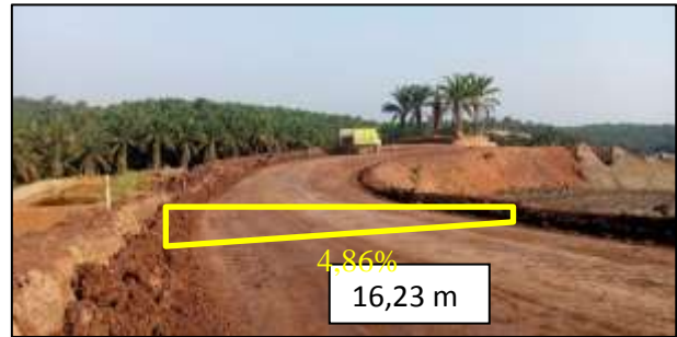
Gambar 4.8 Superelevasi Aktual Jalan Angkut Overburden
