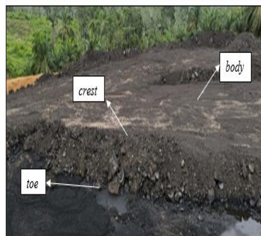
Gambar 4.2 Contoh Crest , Toe dan Body
